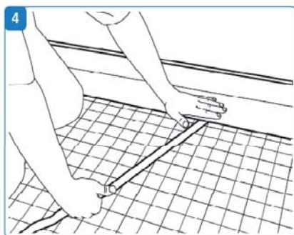
Přilepení fólie obvodového izolačního pásu
